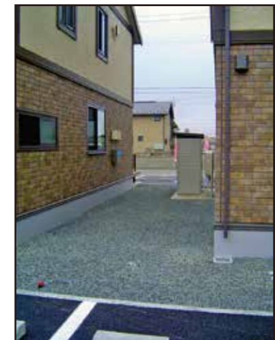
アパート廻りでの施工例
