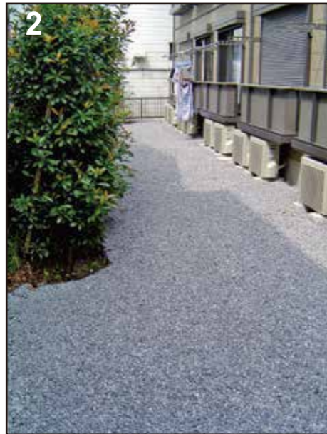
2 砂利(5号碎石)敷き詰め完了
