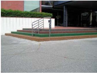
●南富良野／総合福祉センター
