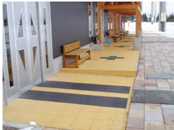
●中標津町／スケートリンクハウス
