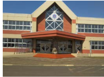
●石狩市／石狩八幡小学校
