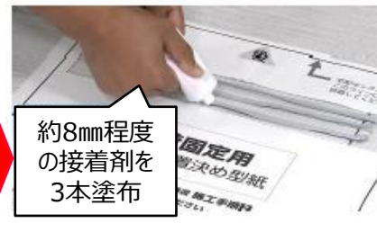
型紙をセットし、台座取り付け 位置に接着剤を塗布 (推奨接着剤 ユニシ製 品番#05653または#05781)
