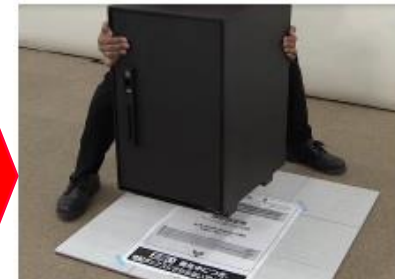
接地面に固定し、24時間程度で 通常使用可能 接着剤硬化後に、型紙をはずして完了 (接着剤の完全硬化は10日程度必要)
