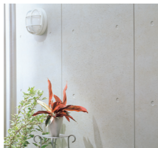
コンクリート打ちっ放し (3 尺)
