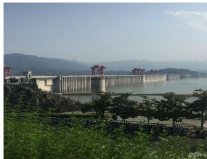
放水設備 概観
