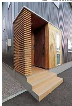
HSS/TRW-19 施工：渋谷建設株式会社
