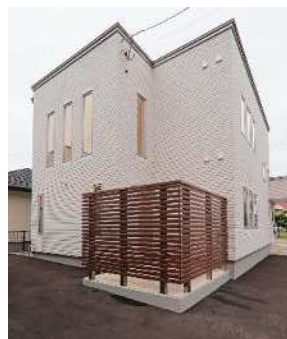
SSS 施工：小島建設株式会社
